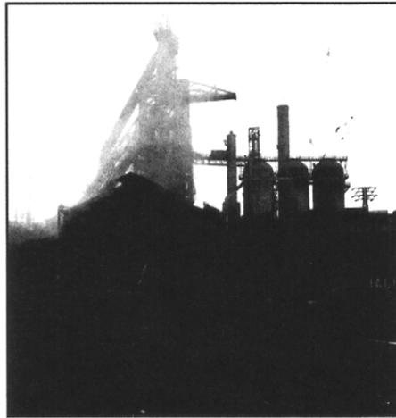
La obtención del fierro se realiza en un Alto Horno, a partir de la siderita, básicamente.
